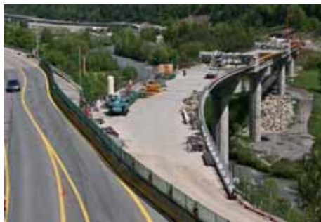
Viaduc aval du Centron (ici en construction), vu de la sortie du Tunnel du Siaix (Cliché Jacques Mossot, Structurae, http://fr.structurae.de/ ).
