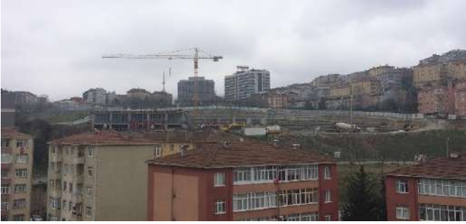
Planche 13 – Photo - Construction d'un stade de quartier et d'un parking souterrain dans le quartier de Küçükköy Gaziosmanpaşa. Prise de vu du balcon de mon logement. Source : Photographie N.R 21/03/2019.
