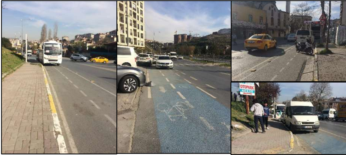
Planche 54 – Photo - Des véhicules motorisés stationnent sur la piste cyclable. Source : Photographie N.R 19/03/2019
