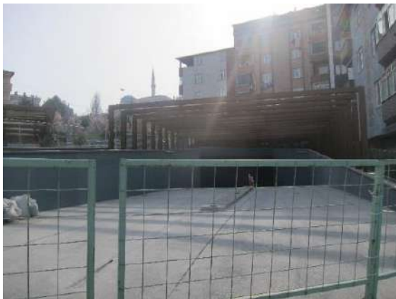
Planche 12 – Photo - Construction d'un parking souterrain avec une aire de repos au-dessus dans le quartier de Cengiz Topel Eyüp. Source : Photographie N.R 16/03/2019.
