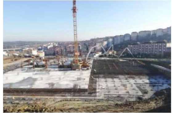
Planche 15 – Photo - Construction d'un stade de quartier et d'un parking souterrain dans le quartier de Küçükköy Gaziosmanpaşa, projet en construction. Source : IBB Smart city projeler.
